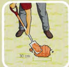
Löcher für die Zaunpfosten graben.
